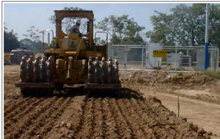
Figura 25. Colocación de encapsulado
