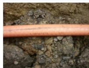
Imagen 11. Tendido de la tubería sobre rocas.
