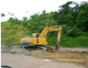
Imagen 6. Apertura de la zanja
