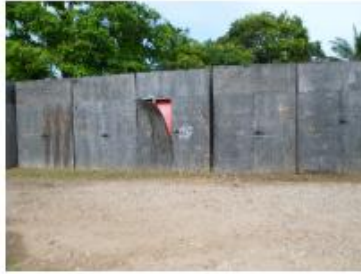
Imagen 1. Lugar de almacenamiento
