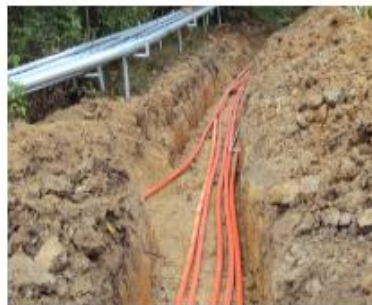
Imagen 16. Instalacion de varias lines en una zanja
