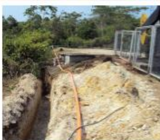
Imagen 10. Halado por la zanja se realizó manualmente
