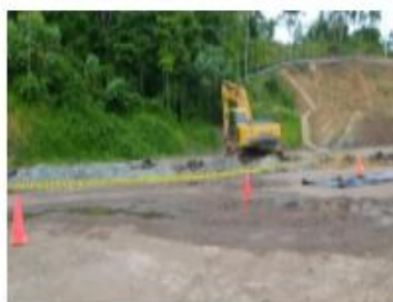
Imagen 13. El campo con las respectivas señales de seguridad.
