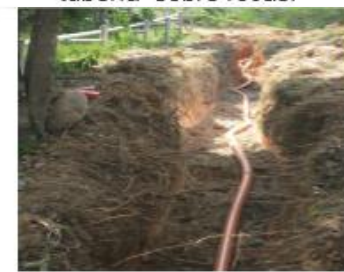
Imagen 14. el tendido de la tubería se realiza de manera curva,
