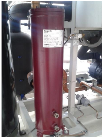
Imagen. 19. Tanque de Aceite sistema de Refrigeración Lan Cargo.
