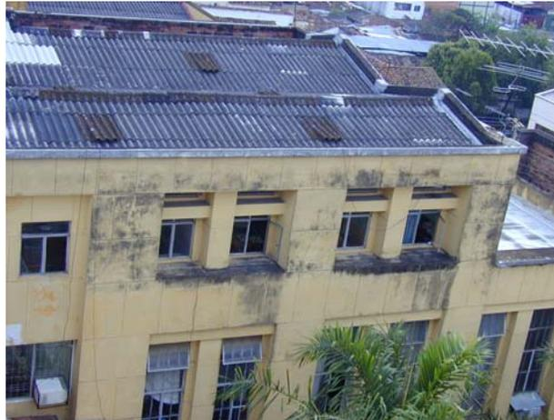
**FIGURA 25.** Arreglos locativos Gobernación. Cubierta deteriorada de Contraloría.
