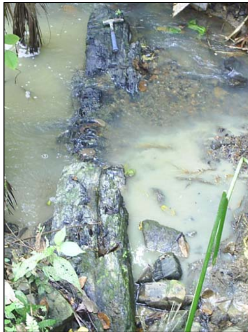
Figura 70. Manto de carbón alterado por el paso del agua.
