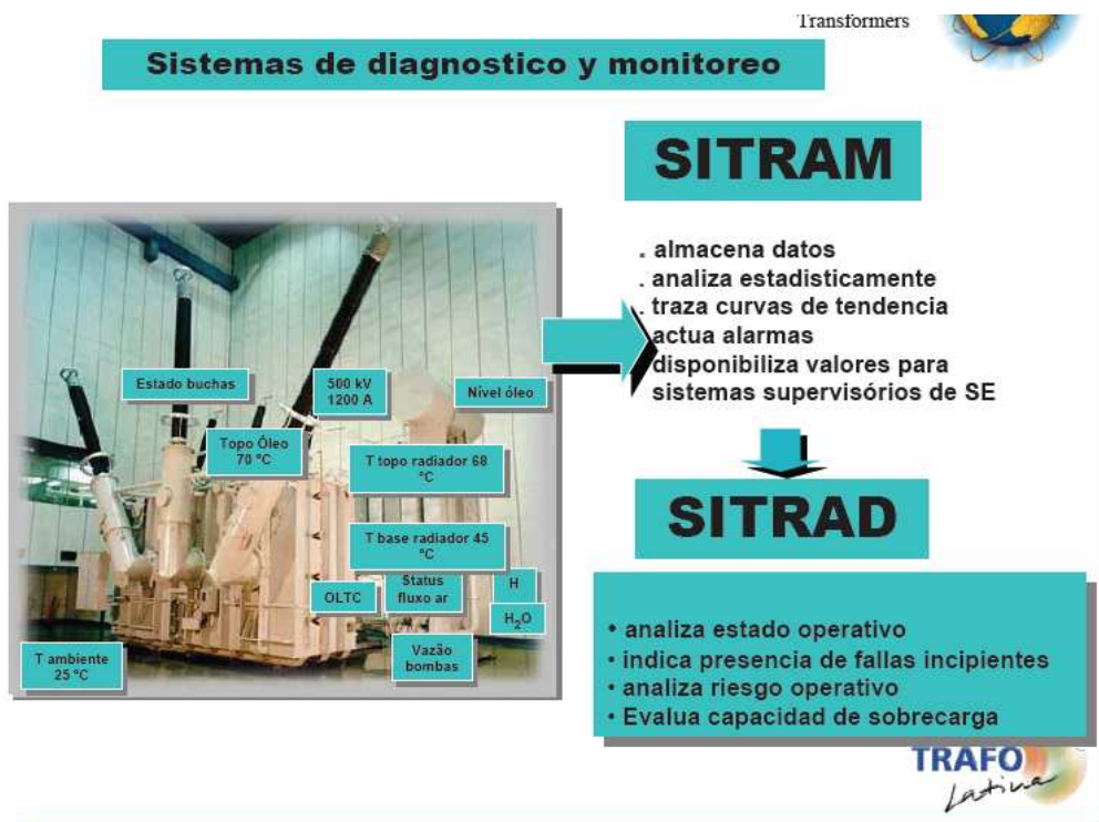
Figura 17. Sistemas de Monitoreo y Diagnostico de Transformadores
