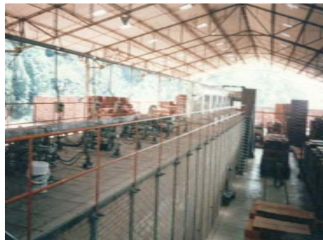
Figura 4.10. Vista del horno en la planta
