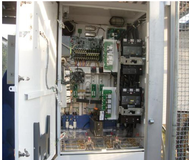
Figura 29. VARIADOR CENTRILIF 110KVA
