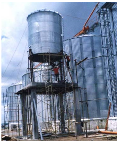
Figura 161. Instalación soportes silo de granel
