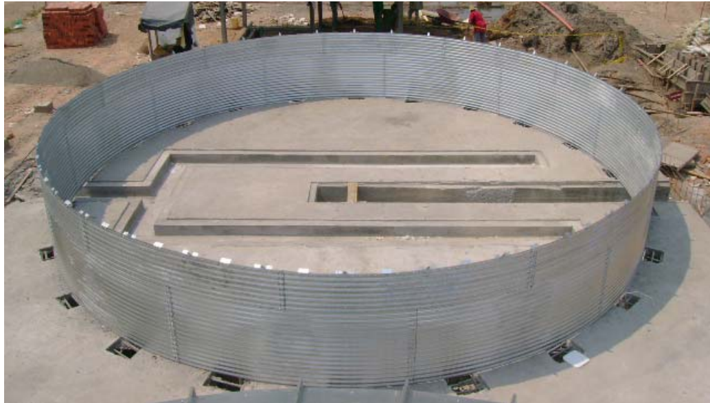
Figura 46. Fosos sinfín descarga silos y sistema de ventilación.
