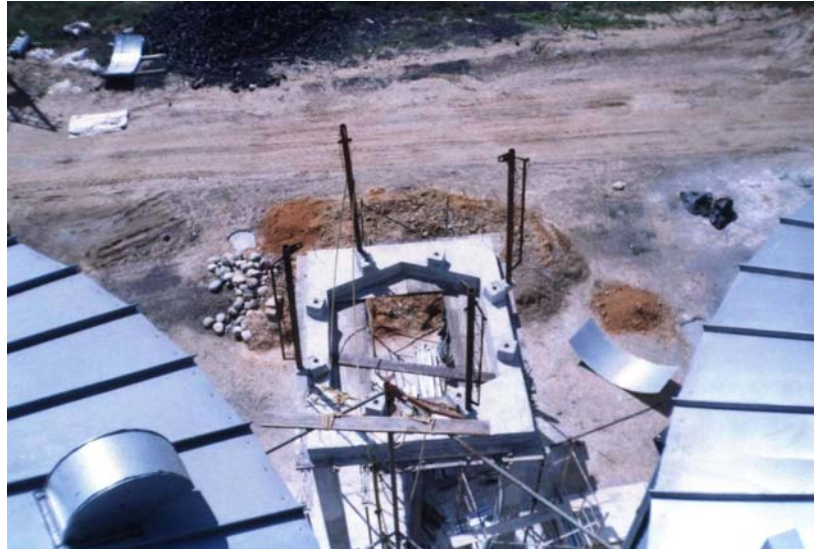
Figura 158. Instalación postes de alzada para silo a granel
