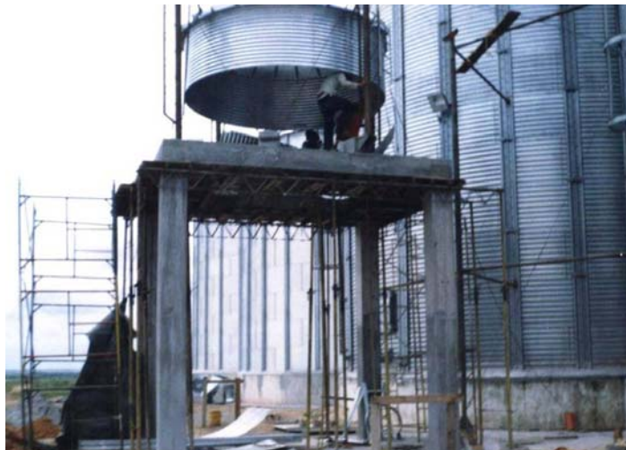
Figura 160. Alzada primer anillo silo a granel
