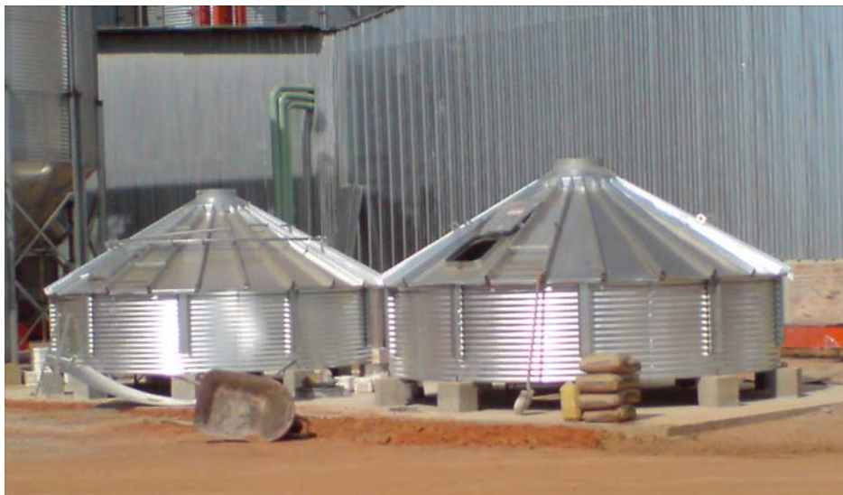
Figura 130. Techos y primer anillo silos de trabajo
