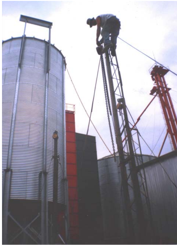
Figura 132. Ubicación postes para alzada del segundo silo de trabajo
