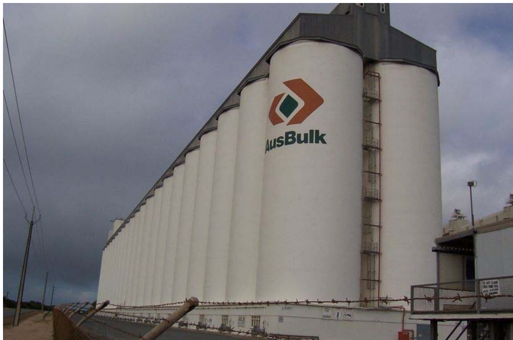
Figura 10. Silos de concreto
