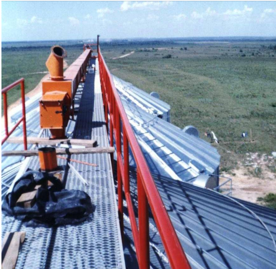
Figura 142. Montaje transportador TC-03
