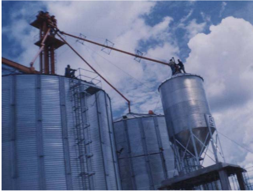
Figura 164. Montaje tubería de carga silo a granel
