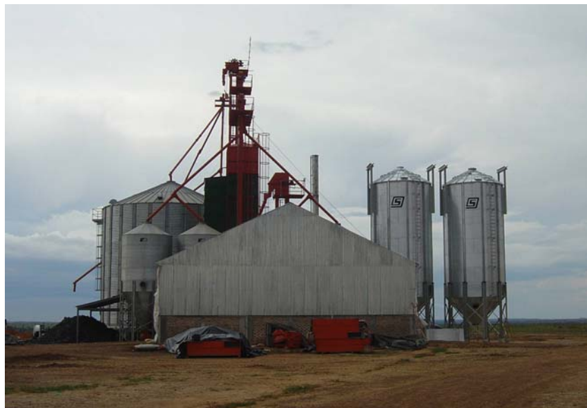
Figura 134. Montaje silos de trabajo finalizado
