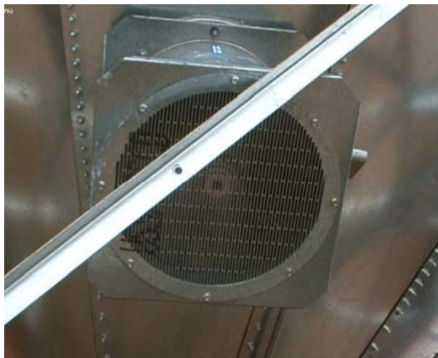
Figura 173. Arranque sistema de ventilación silos de trabajo
