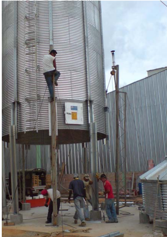
Figura 131. Elevación e instalación de las columnas del primer silo de trabajo
