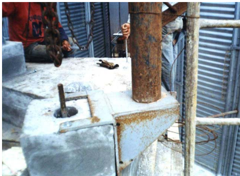
Figura 159. Soporte para postes de alzada silo de granel
