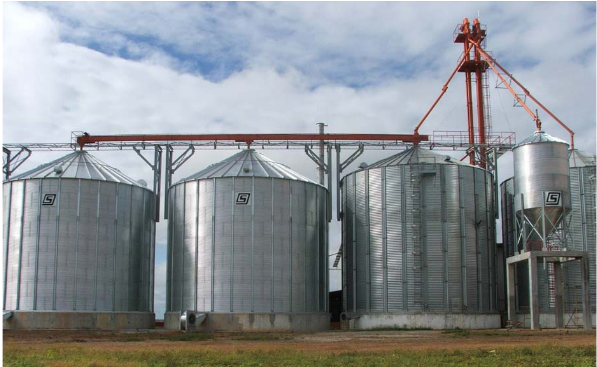
Figura 168. Montaje final silos de almacenamiento y granel
