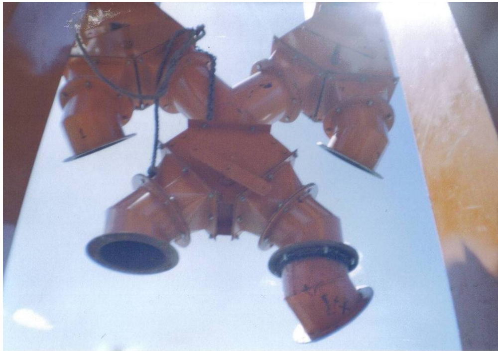
Figura 163. Instalación cajas de cambio salida elevadores
