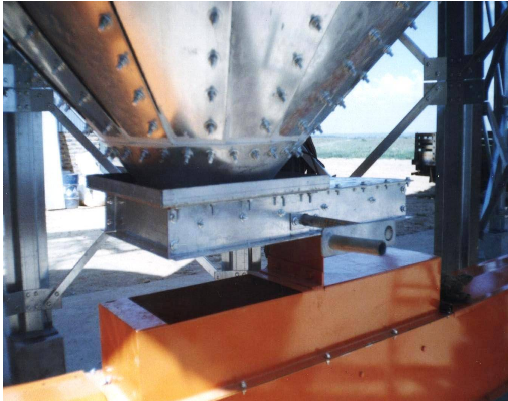
Figura 137. Montaje TC-02, acople silos
