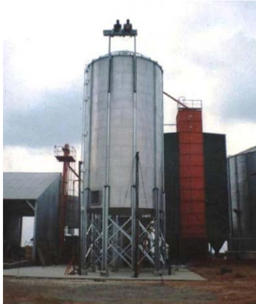
Figura 133. Silos de trabajo sin cono
