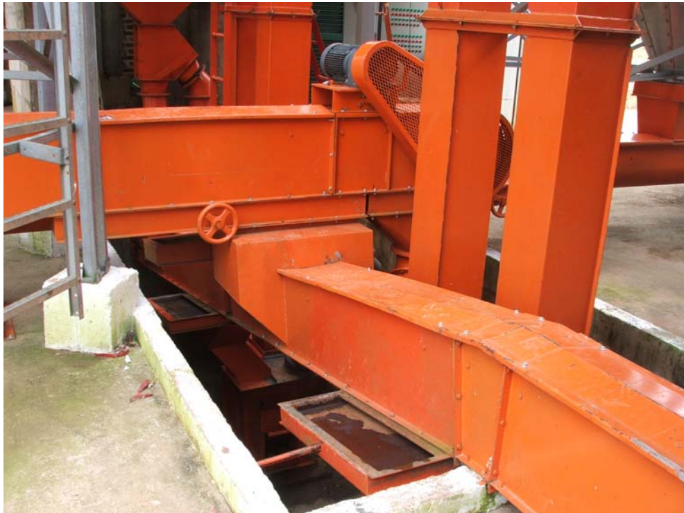
Figura 135. Montaje TC-02 acoples elevadores
