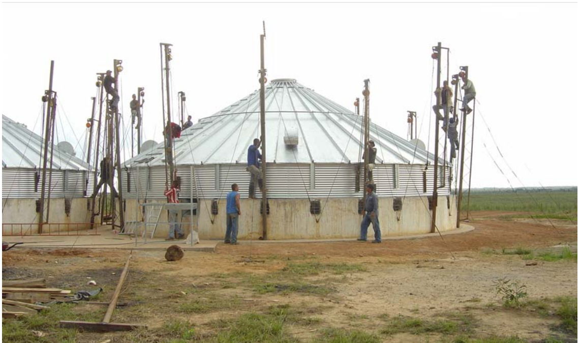
Figura 121. Montaje techo y primer anillo
