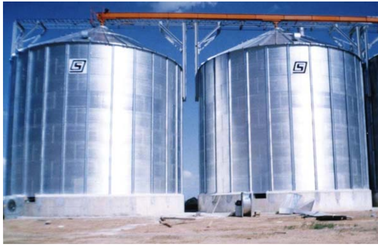
Figura 150. Instalación ventiladores sistema de ventilación
