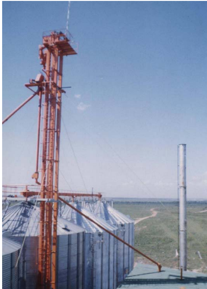
Figura 128. Montaje cabezotes elevadores
