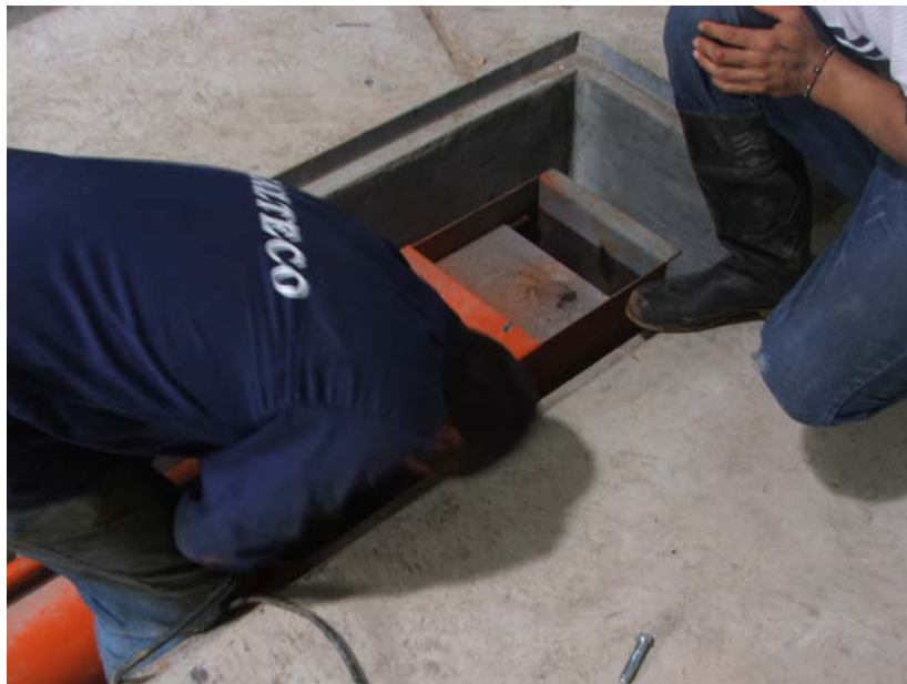
Figura 145. Montaje sinfín de descarga silos
