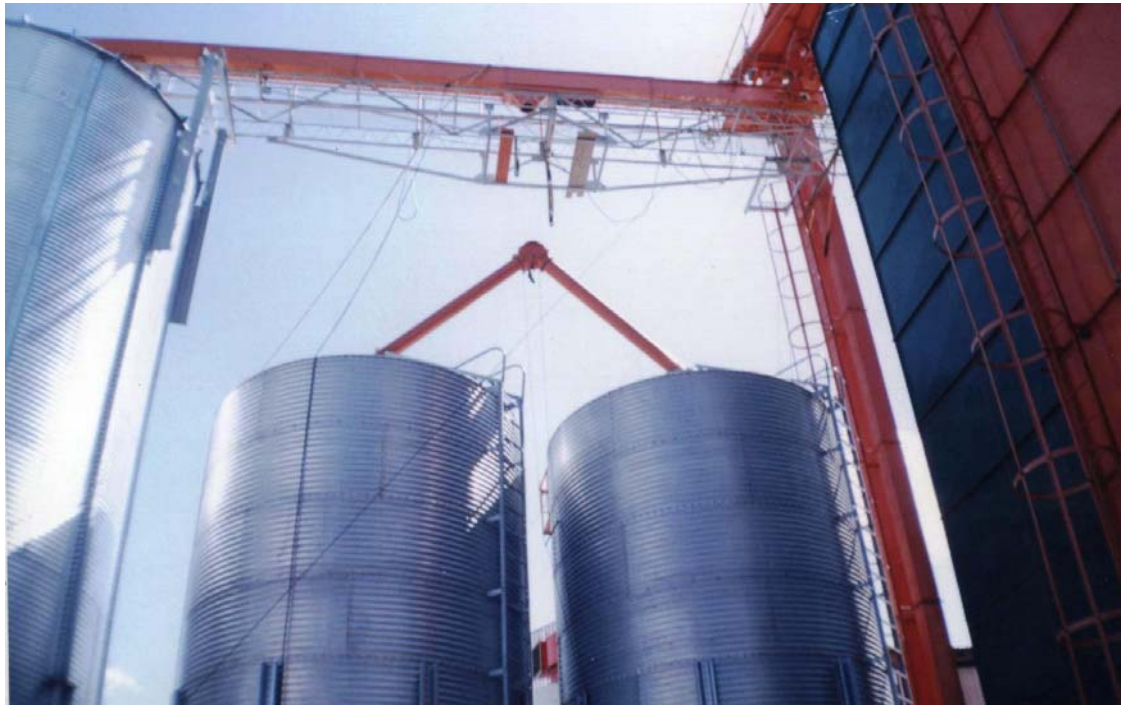
Figura 140. Montaje ductos de descarga TC-01
