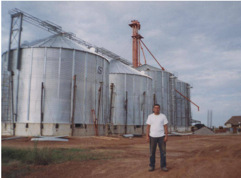
Figura 125. Erección silos de almacenamiento
