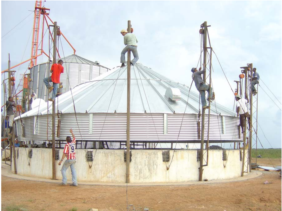
Figura 122. Alzada primer anillo
