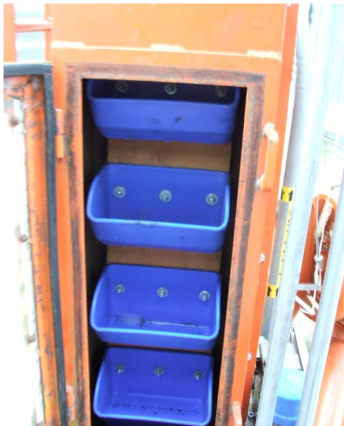
Figura 127. Montaje cangilones alargue elevador EL-04
