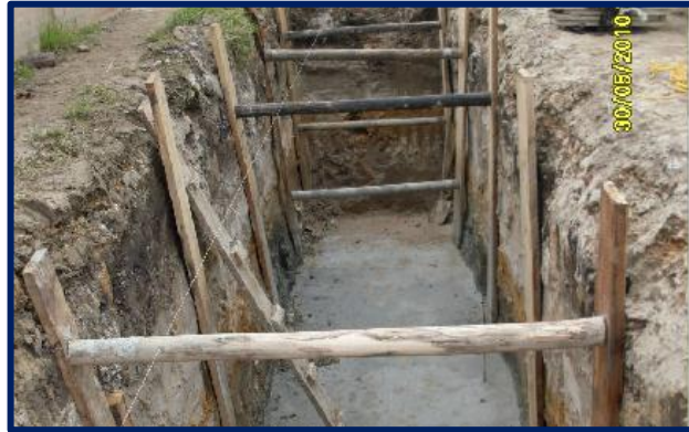
Figura 5. Entibación de Excavación
