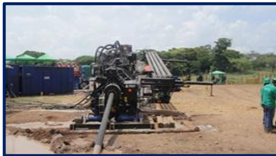
Figura 23. Equipo de Perforación
