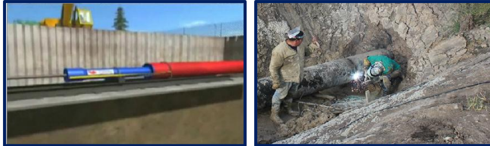
Figura 7. Hincado y Soldadura de la Tubería
