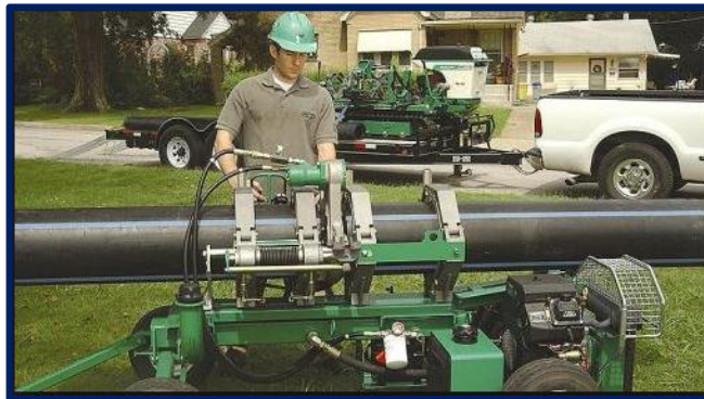
Figura 10. Equipo de Soldadura
