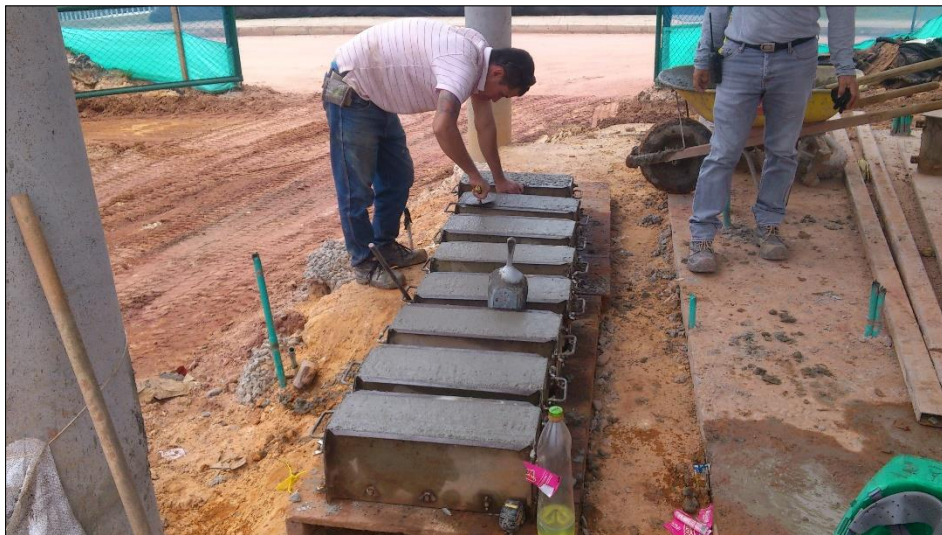
Figura 32. Elaboración de viguetas
