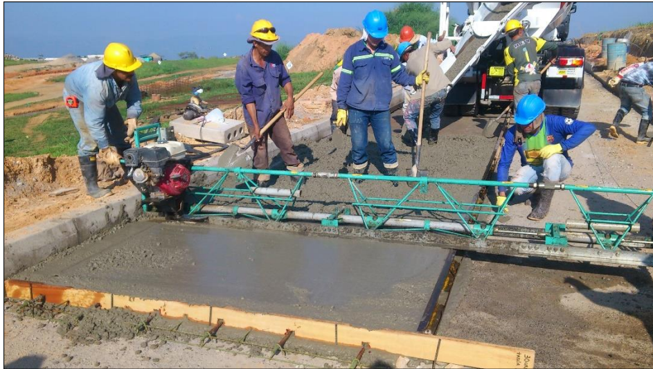
Figura 17. Fundida de vía en pavimento rígido
