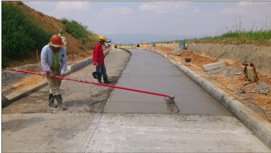
Figura 18. Alisado del pavimento fundido
