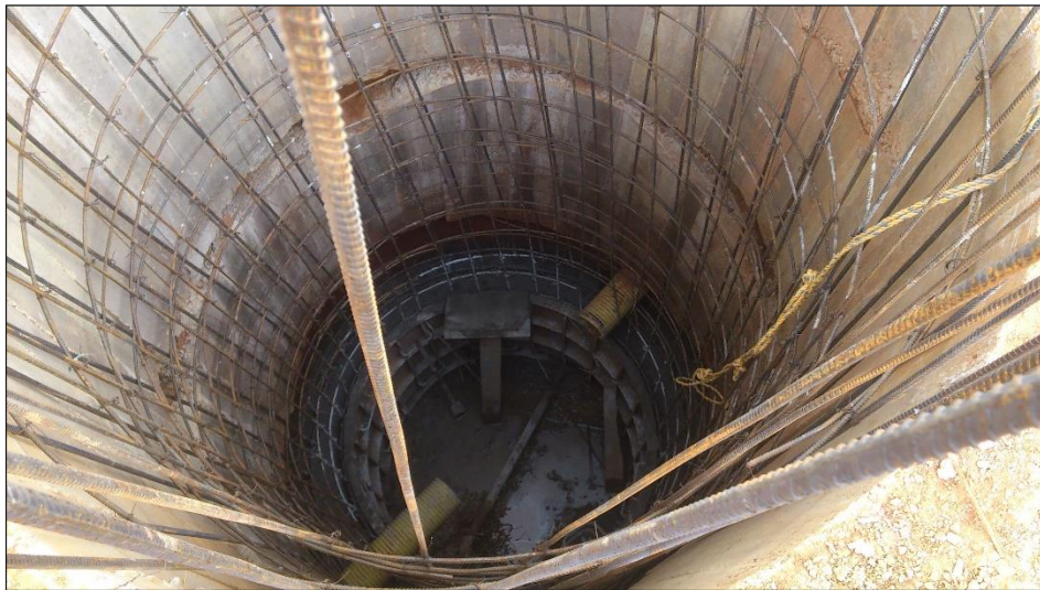
Figura 27. Primer anillo pozo de bombeo aguas negras
