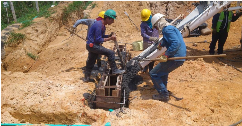
Figura 26. Fundida de sumidero
