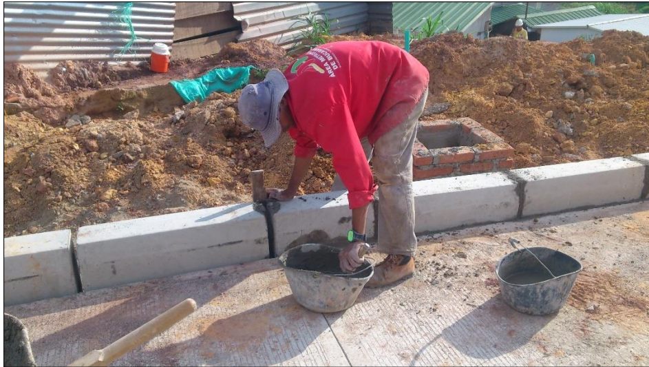
Figura 22. Armado de sardinel
