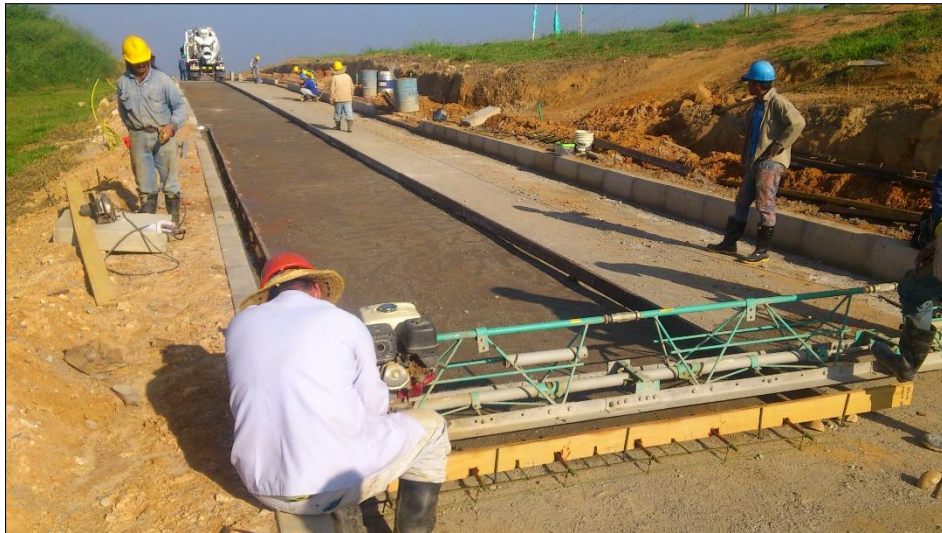
Figura 15. Formaleta armada para vía en pavimento rígido
