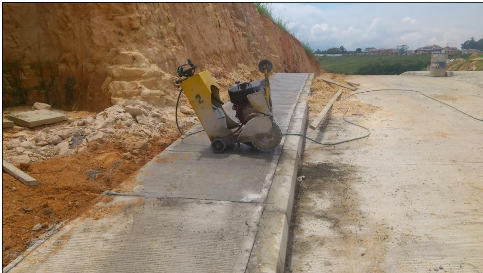
Figura 24. Corte de dilatación en andén
