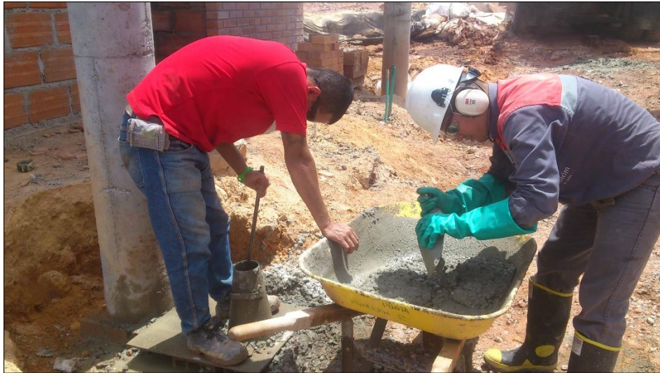
Figura 30. Ensayo de asentamiento
