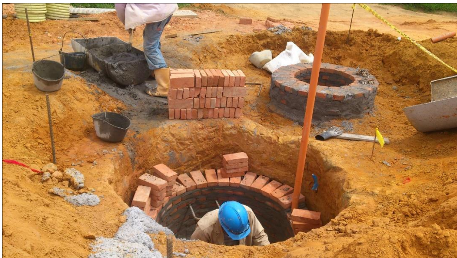
Figura 25. Anillo en mampostería de pozo de inspección
