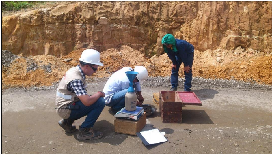
Figura 14. Ensayo Cono de arena
