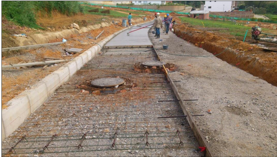
Figura 16. Instalación aceros de refuerzo para vías
