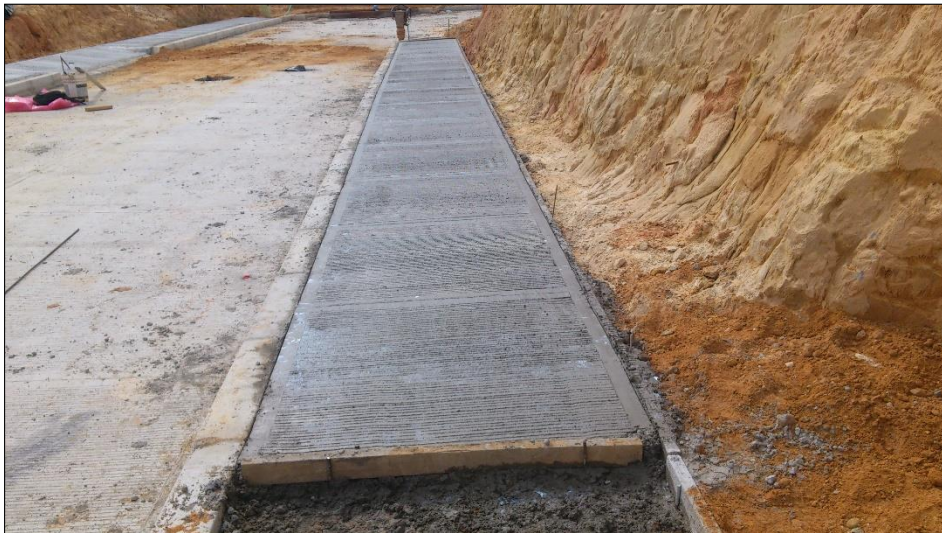
Figura 23. Acabados del andén
