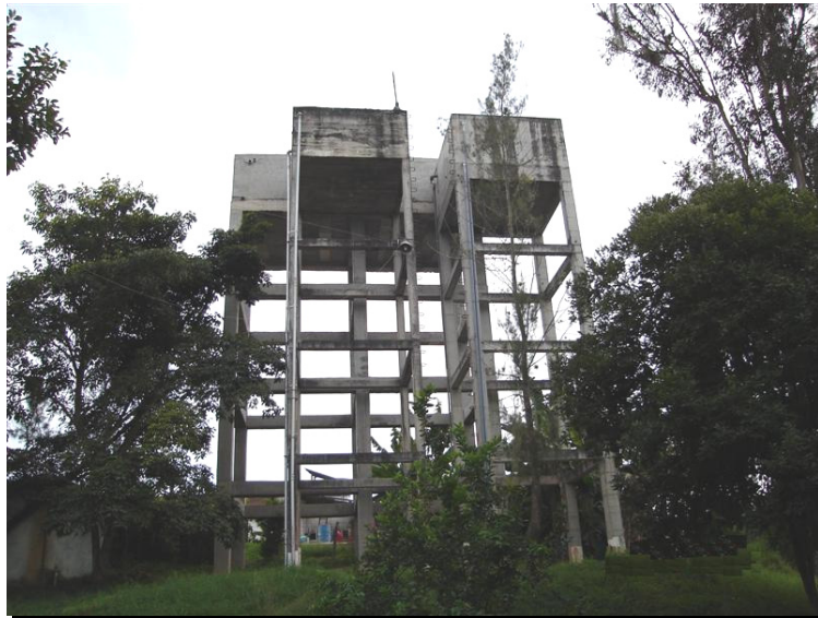
Foto A.8.4. Tanques elevados ubicados en la planta de tratamiento de agua potable. Al fondo se puede observar un tercer tanque en construcción
