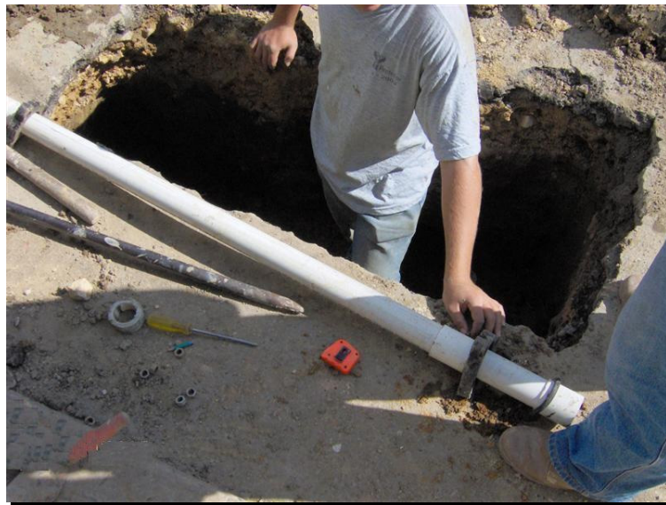
Foto A.8.8. Reparación por rotura de tubería
