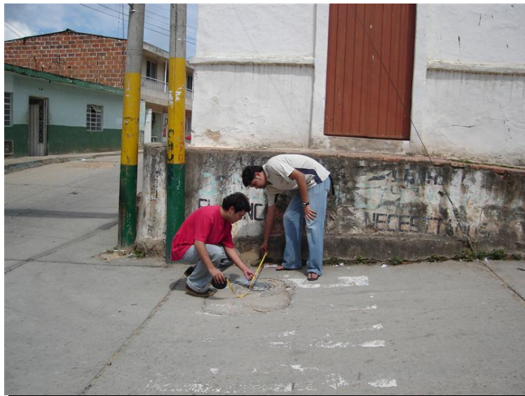
Foto A.8.2. Recolección de la información sobre localización de válvulas mediante mediciones con cinta, referenciándose a lugares de ubicación conocida.
