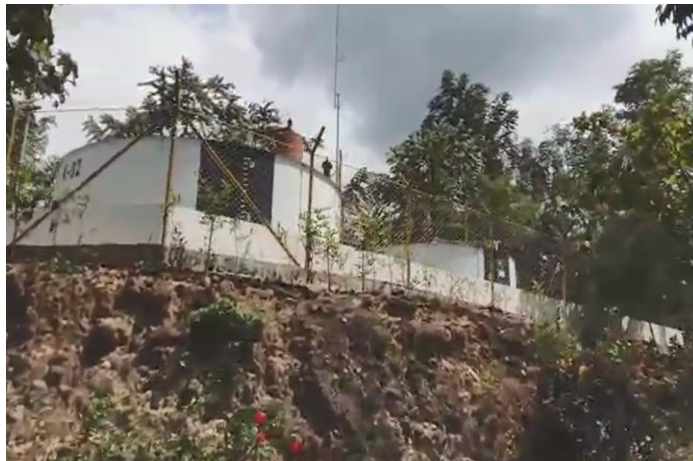
Figura 26. Tanque de Almacenamiento del Campo San Luis
