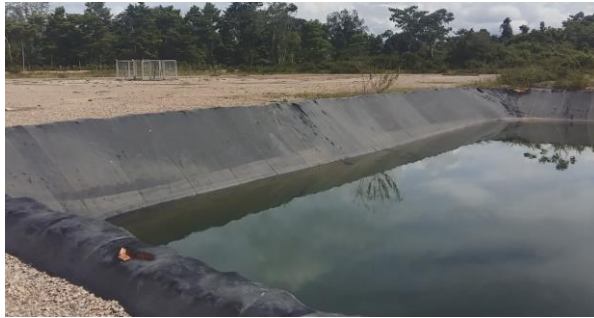
Figura 17. Piscinas Pozo Coyote 1 año 2016
