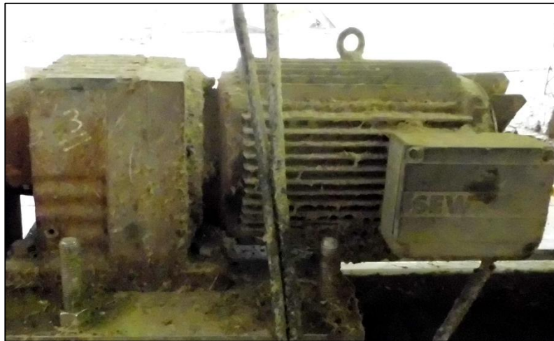
Figura 36. Montaje del sistema de transmisión de potencia de los filtros de tambor rotacional.
