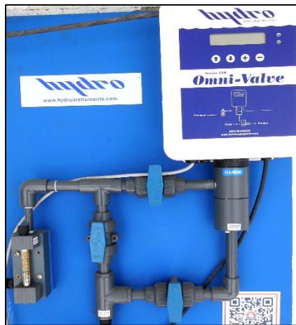
Figura 7. Sistema de cloración de la PTAP.
