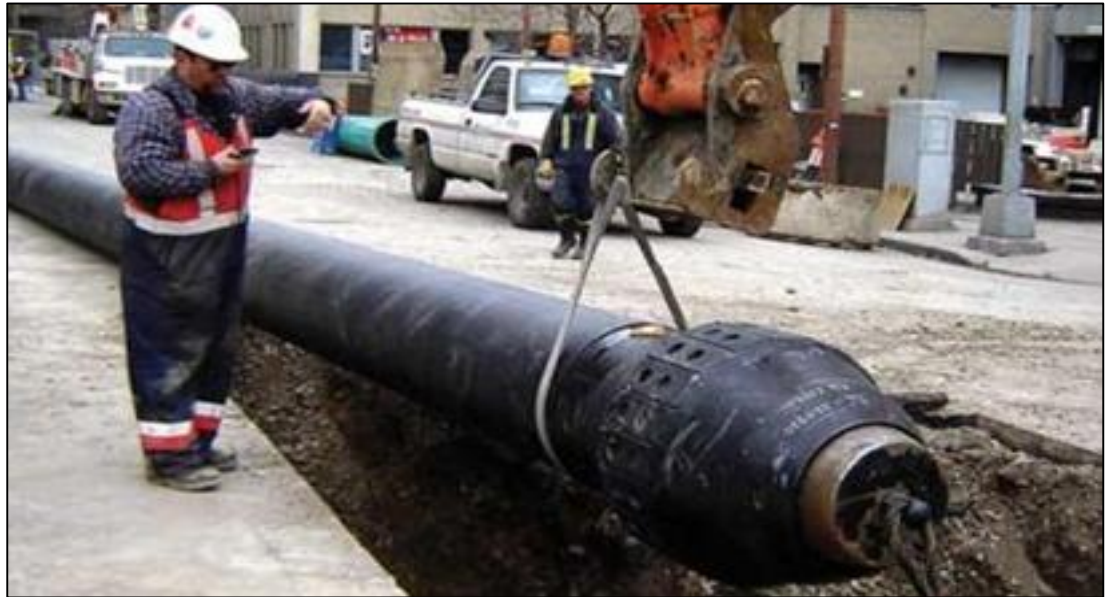
Figura 9. Nuevas tecnologías método TRENCHLESS Fuente http://www.centrasas.com/trenchless--sin-zanja.html
