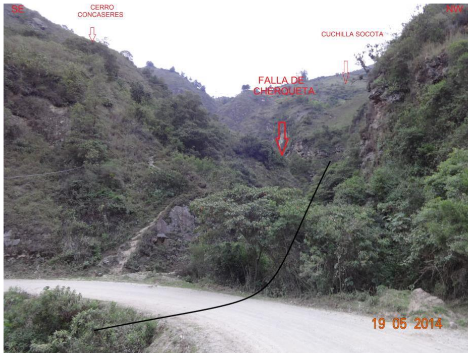
Figura 30. Trazo de la falla de de Cherqueta sobre la quebrada
