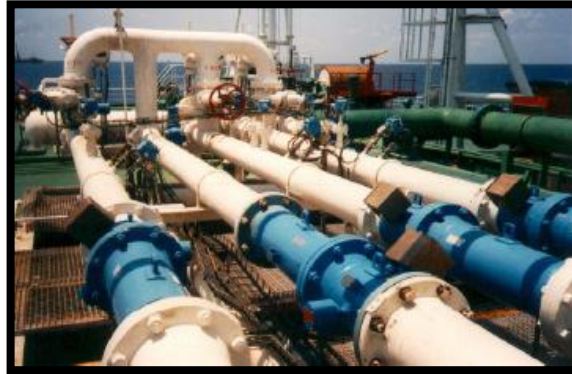
Figura 16. Medidor tipo turbina helicoidal.
