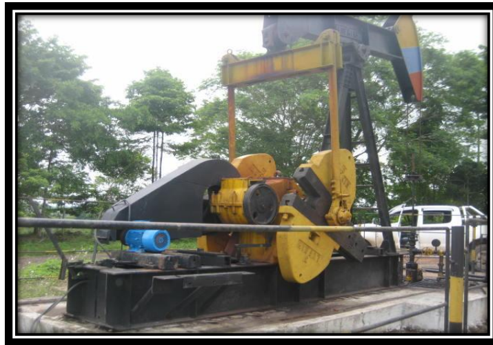
Fig. 9 colorado 38 en funcionamiento no hay presencia de corrosión a la vista
