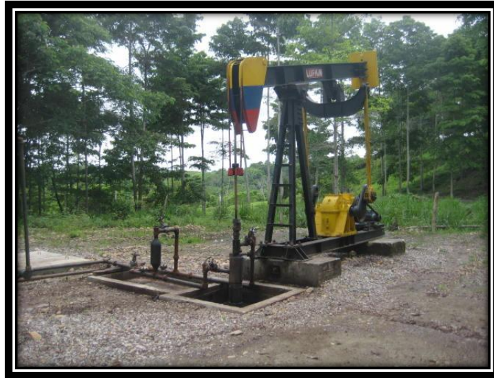
Figura. 11. Colorado 25 en funcionamiento, con tanque de almacenamiento, no se encuentra encerrado.
