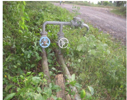
Figura.18 colector general y de prueba con corrosión
