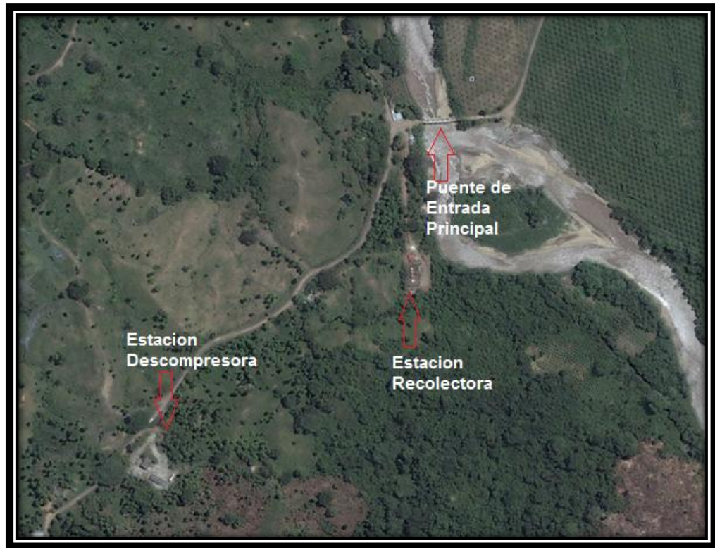
Figura. 7 Muestra la entrada principal al campo, la estación recolectora y la estación descompresora.
