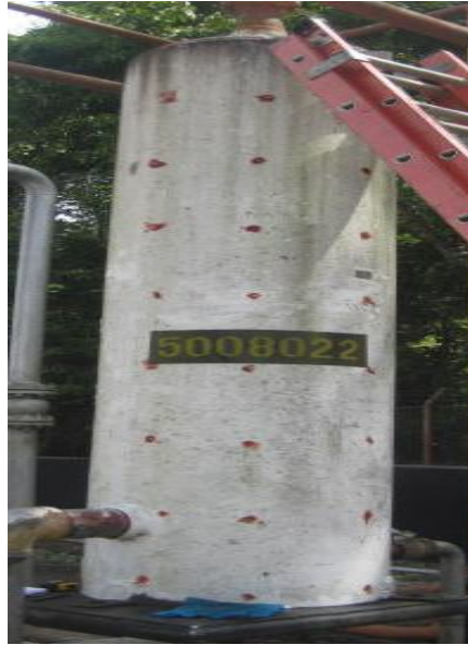
Figura.13 Registro fotográfico de los puntos tomados en el separado de prueba
