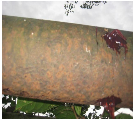
Figura.18 colector general y de prueba con corrosión
