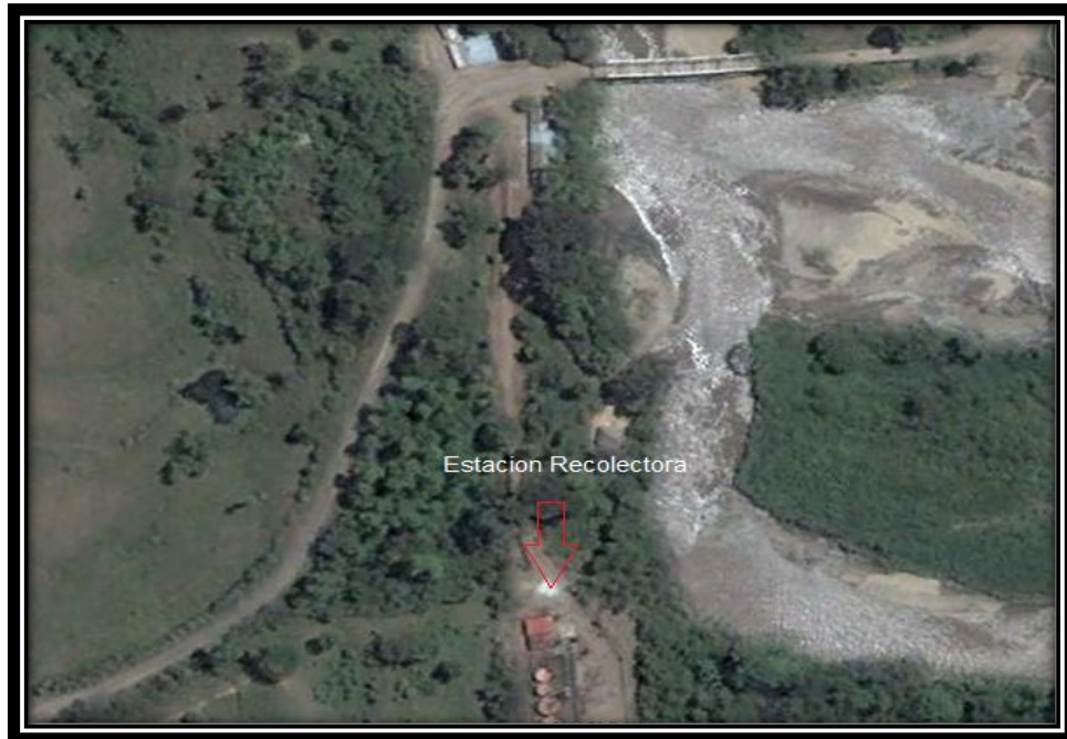
Figura. 41 vista aérea de la estación recolectora.
