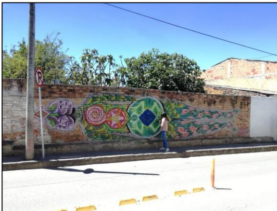
Figura 10. Muro donde se realizaría la puerta.
