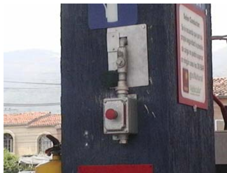
Figura 4.1 Pulsadores de emergencia de la estación El Carmen (Girón – Santander)
