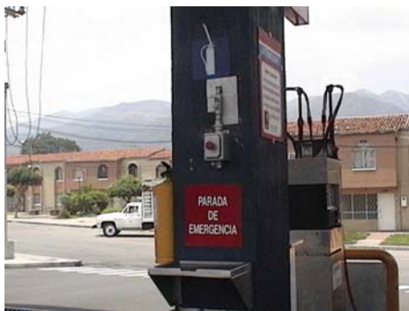
Figura 4.1 Pulsadores de emergencia de la estación El Carmen (Girón – Santander)
