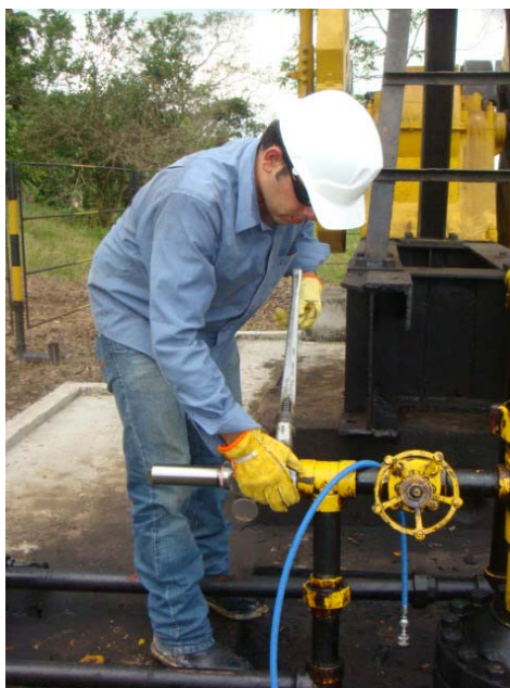
Figura 42. Instalación de la Pistola
