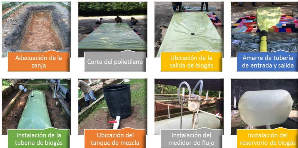
Figura 1. Instalación del BDG
