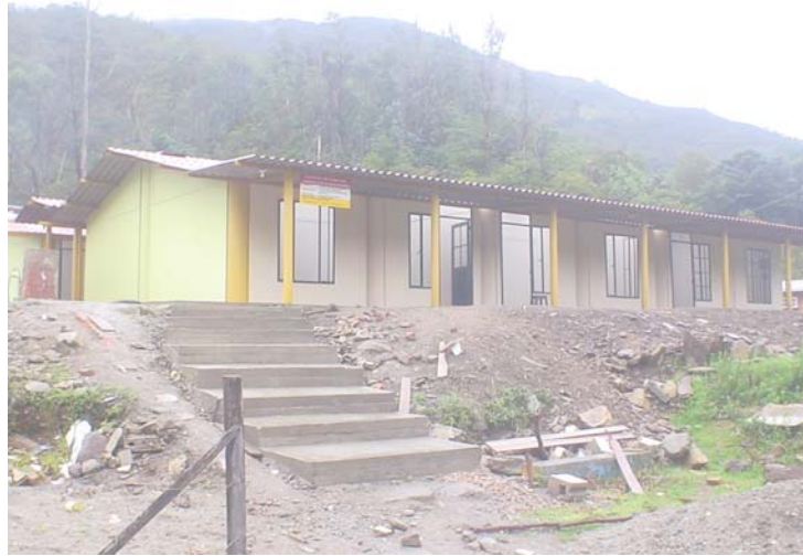
Figura 04: Proceso constructivo Colegio San Miguel
