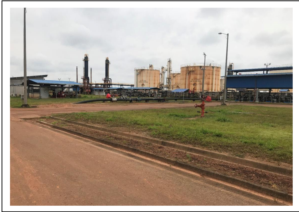
Figura 38. Facilidades Estación Ocelote
