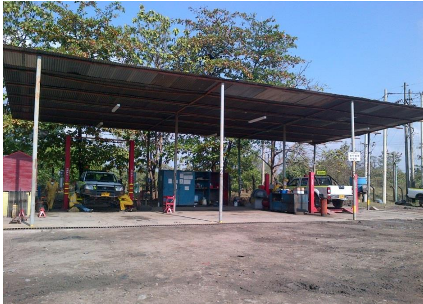
Figura 13. Taller de mantenimiento en la Jagua
