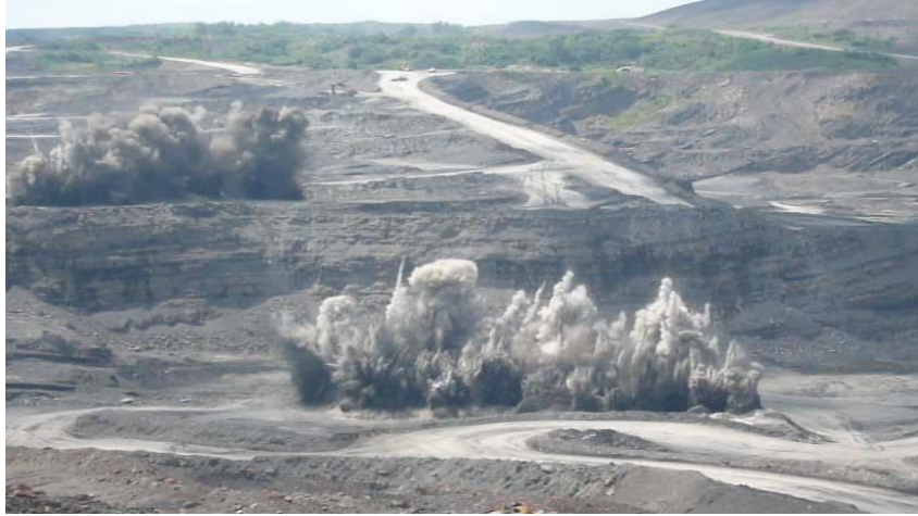
Figura 3. Vista de explosión controlada para voladura
