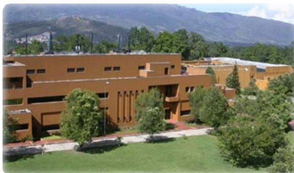
Figura 1. Instalaciones Instituto Colombiano del Petróleo – ICP
