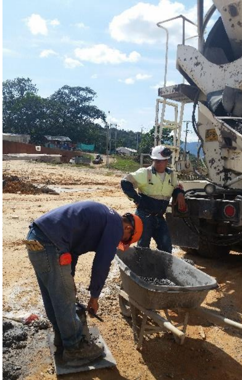
Figura 2. Toma de asentamiento.
