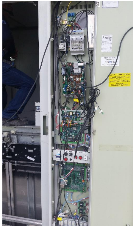
Figura 13. Circuito y control del ascensor.
