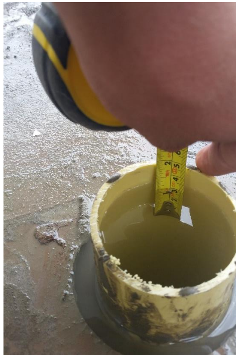
Figura 7. Prueba de estanqueidad
