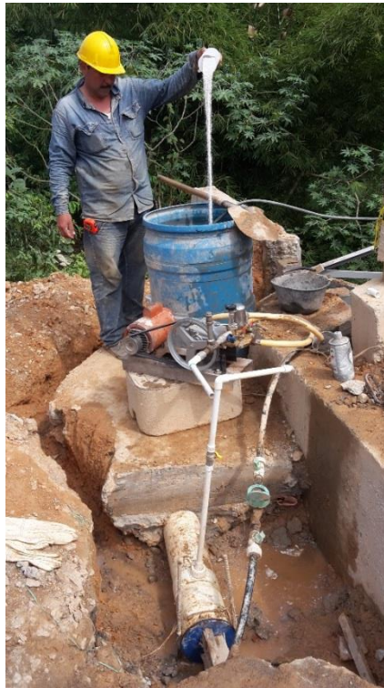
Figura 8. Desinfección de la red externa.
