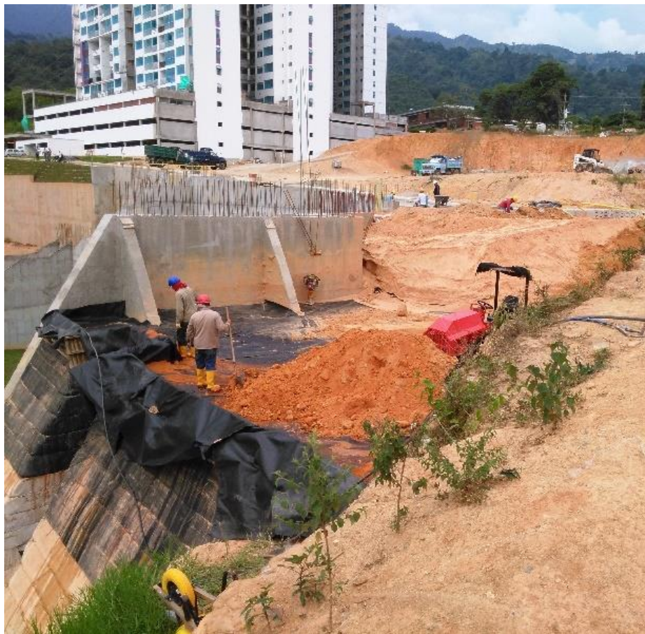
Figura 6. Conformación “capas” muro en tierra armado.
