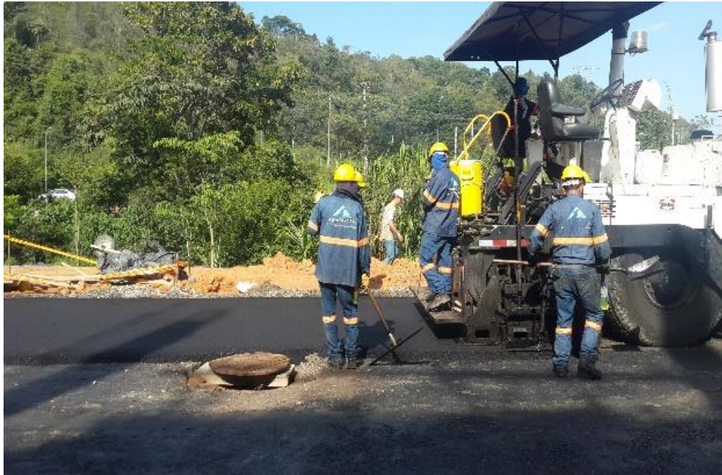
Figura 10. Pavimentación via frente a Monteolivetto.
