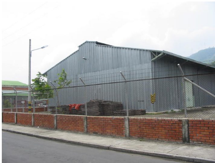
Figura 10. Bodega en estructura de acero
