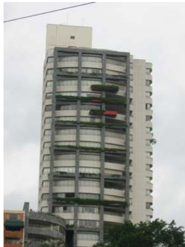
Figura 9. Edificio en pórtico de hormigón
