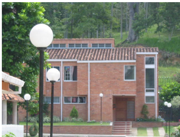
Figura 7. Casa en mampostería confinada
