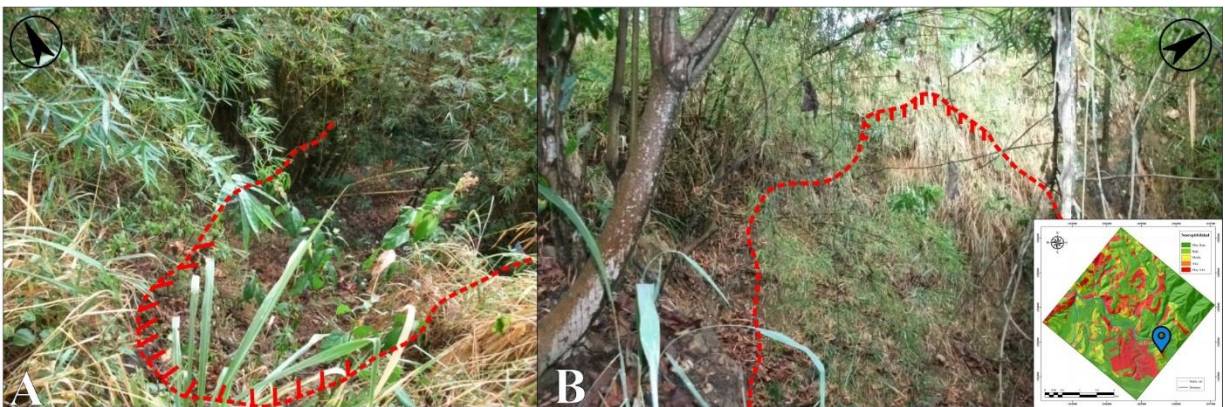
Figura 26. Deslizamiento rotacional visto desde la corona (A) y desde el pie (B) ubicado en franja de Alta Susceptibilidad dentro del respectivo mapa. En zona aledaña a la urbanización Norte Club.
