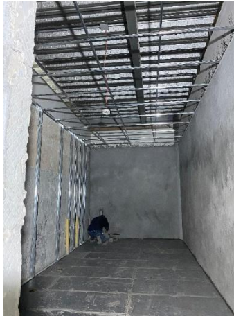
Enchape de piso de las baterías sanitarias
