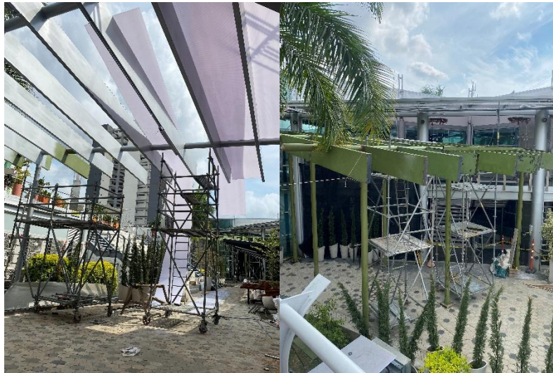
Cubierta edificio principal ESSA Bucaramanga
