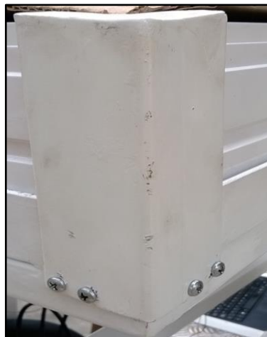
Figura 114. Pieza de fijación del captador-estructura instalado
