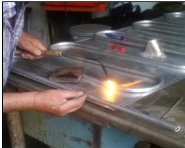
Figura 89. Soldadura de los tubos y la placa absorbidora
