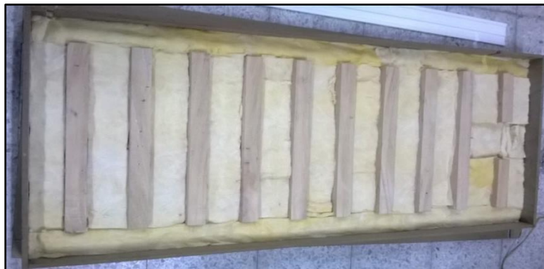
Figura 95. Montaje del aislamiento en el marco interno
