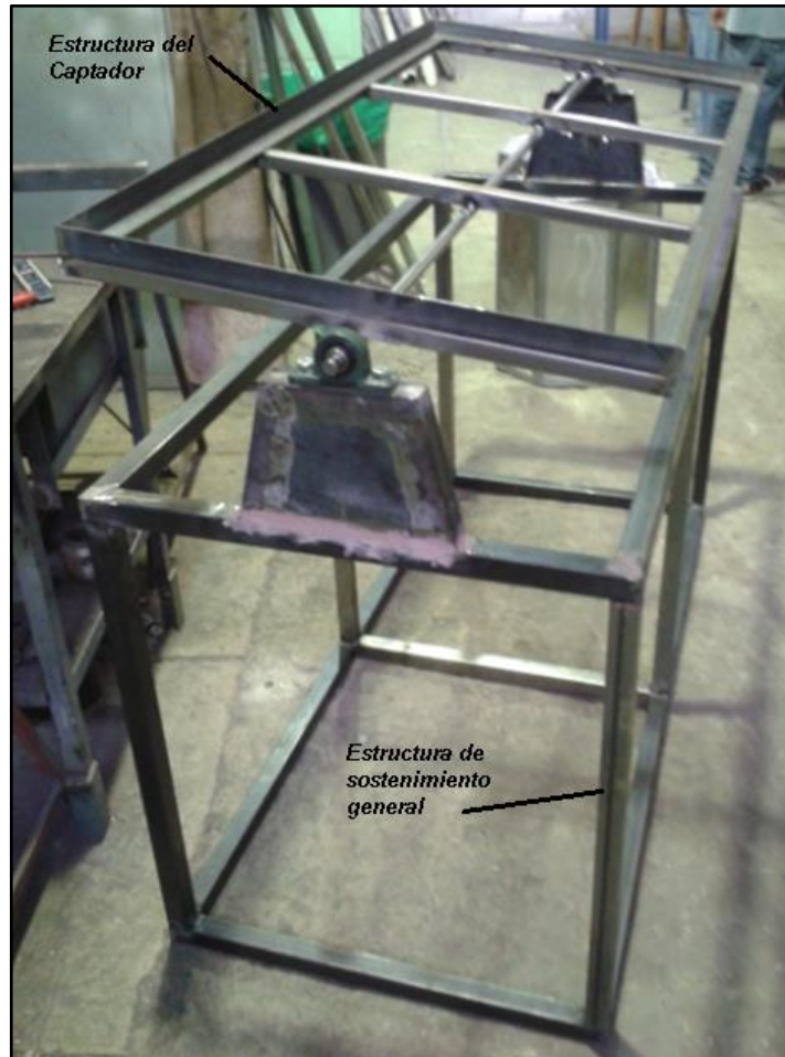
Figura 110. Estructura de sostenimiento sin pintar
