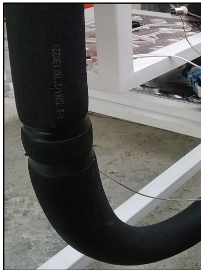
Figura 116. Aislamiento de la manguera
