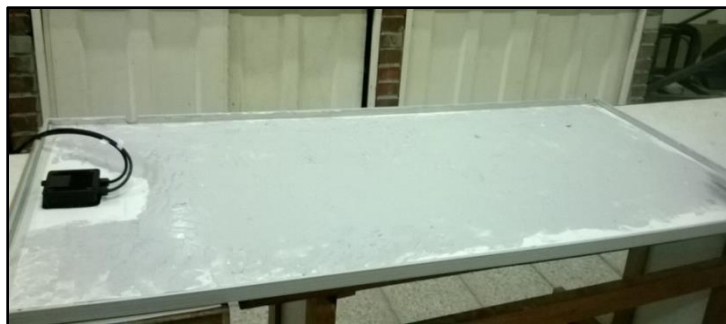
Figura 91. Aplicación del pegante al módulo fotovoltaico
