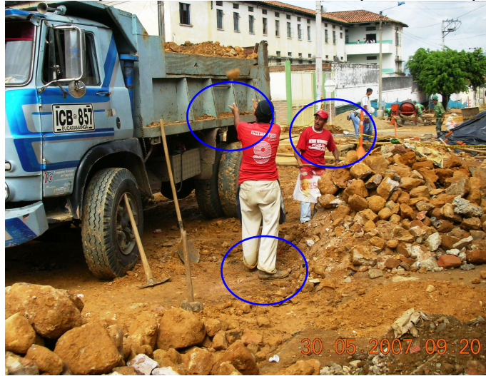
Fuente: Fotografía tomada por Ing. Isley Rincón de Metrolínea S.A.
