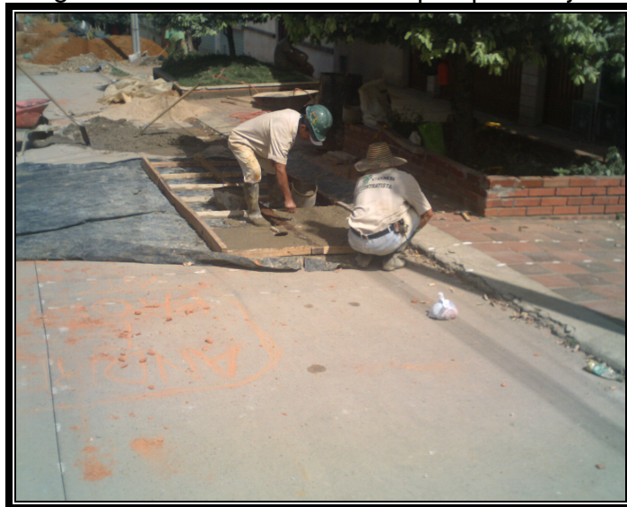
Figura 18. Conformación de tapas para cajas.
