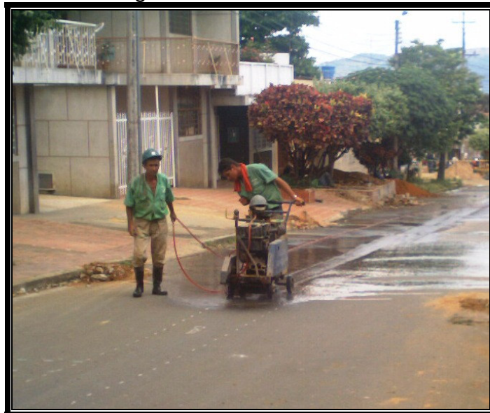
Figura 9. Corte de calzada.
