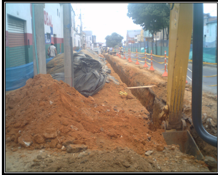
Figura 13. Excavación Mecánica
