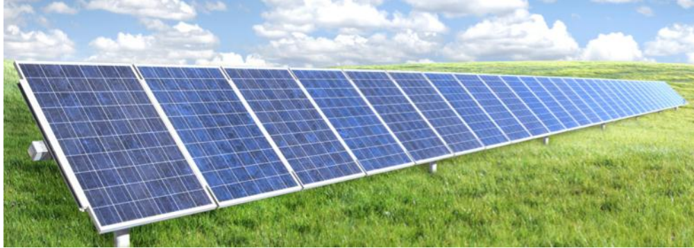
Figura 67: Separación entre módulos Este – Oeste de un sistema FV.
