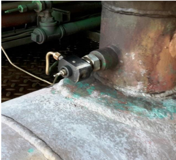
Figura 30. Switch temperatura descarga cilindros compresores, marca amot modelo 4075
