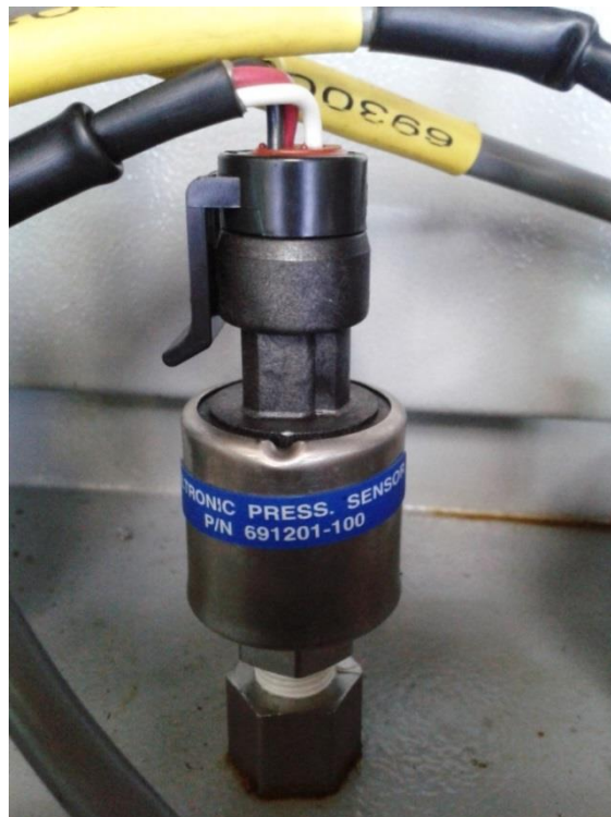
Figura 17. Transductor de presión 0-100 psi
