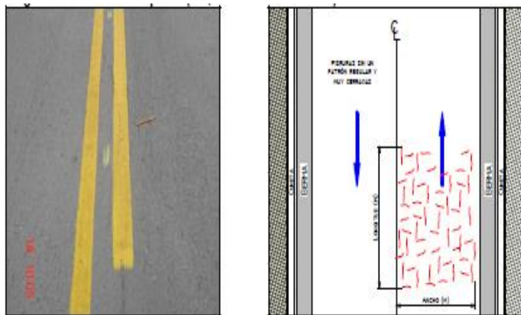
Figura 30. Fisuración incipiente (FIN).
