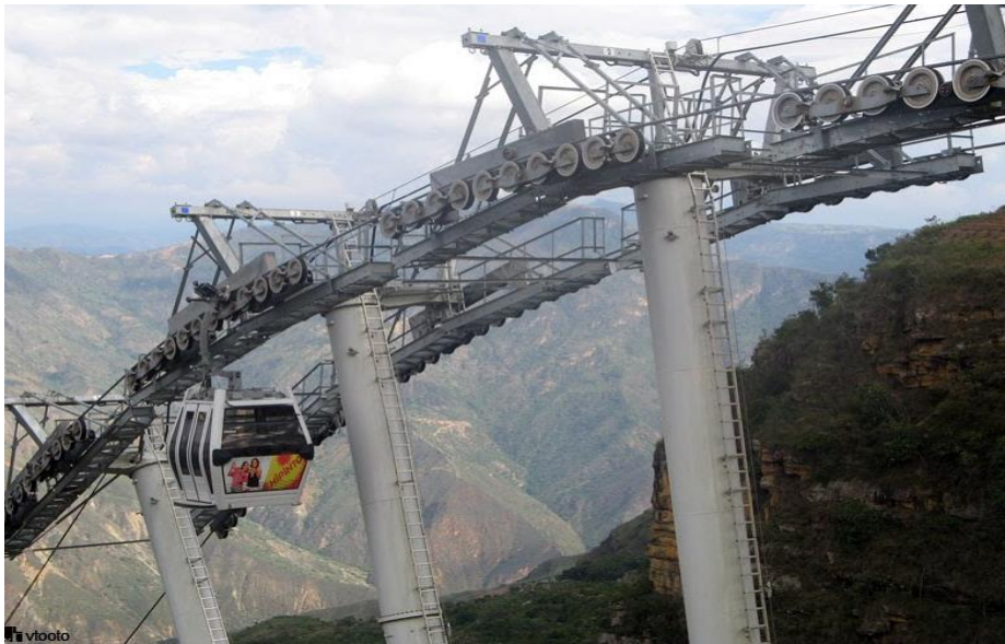
Figura 3. Estación la Plazuela.
