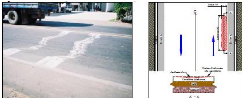
Figura 34. Ahuellamiento (AHU).
