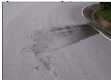
Figura 47. Afloramiento de agua (AFA).
