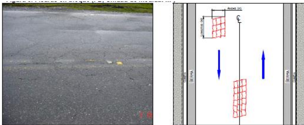
Figura 27. Fisuras de bloque (FB).
