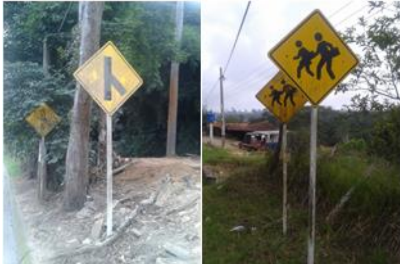
Figura 51. Señales repetidas de incorporación de tránsito desde la derecha (SP-22) y de zona escolar (SP-47).
