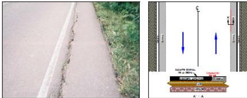
Figura 45. Separación de la berma (SB).
