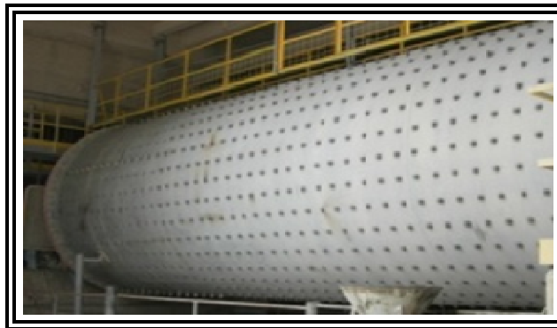
Figura 48: Molienda del cemento
