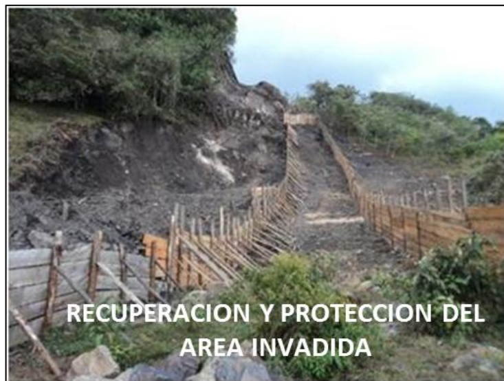
Figura 36. Recuperación y protección del área invadida.
