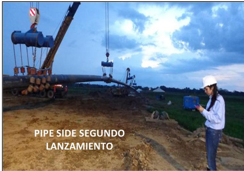
Figura 58. Segundo lanzamiento de la lingada.
