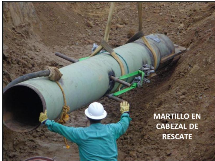
Figura 53. Martillo en cabezal de rescate.
