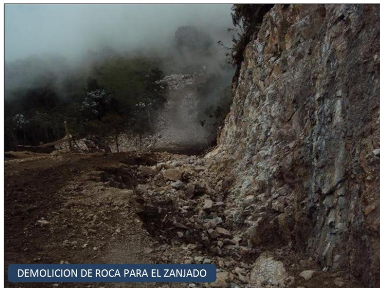
Figura 42. Demolición de roca para el zanjado.
