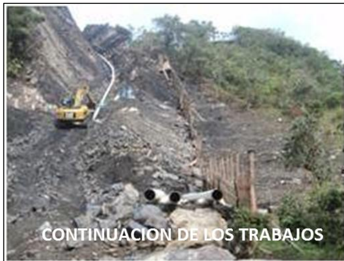
Figura 38. Continuación de los trabajos.
