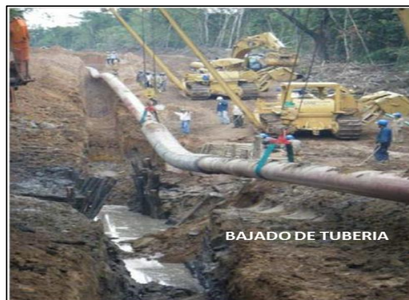
Figura 22. Bajado de la tubería.
