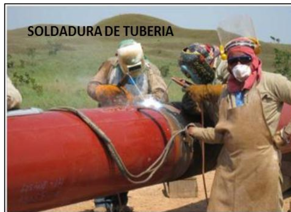
Figura 20. Soldadura de tubería.
