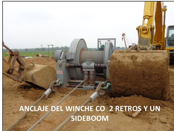
Figura 56. Anclaje del Winche con 2 retroexcavadoras y sideboom.
