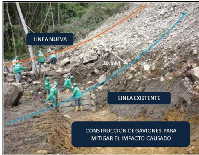
Figura 41. Construcción de gaviones para mitigar el impacto causado.
