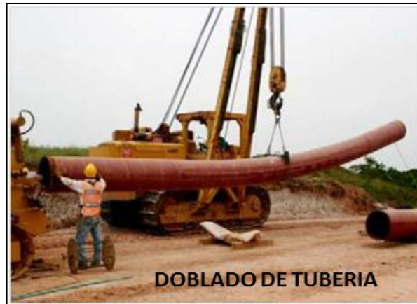
Figura 19. Pre-doblado y doblado de tubería.
