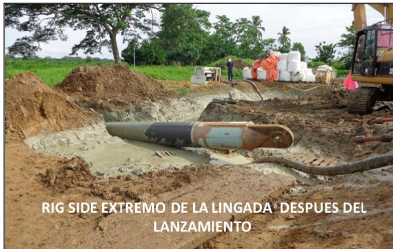
Figura 59. Lanzamiento exitoso de la lingada.
