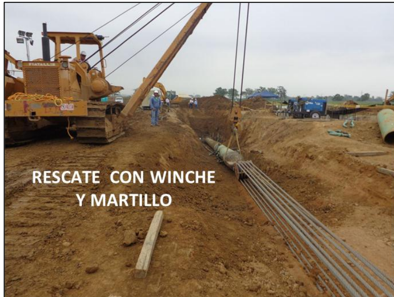
Figura 55. Rescate con Winche y martillo.
