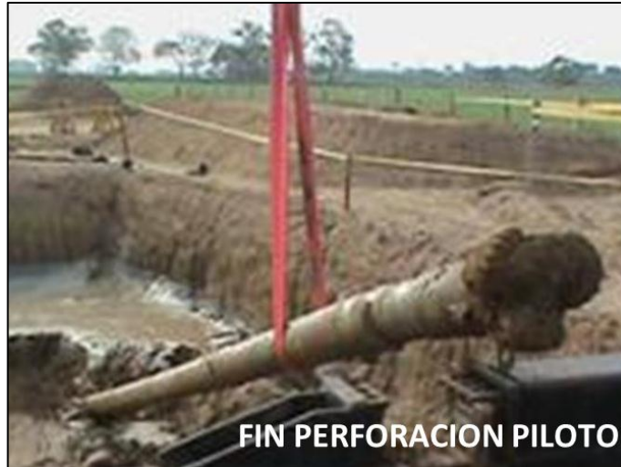
Figura 49. Fin perforación piloto.
