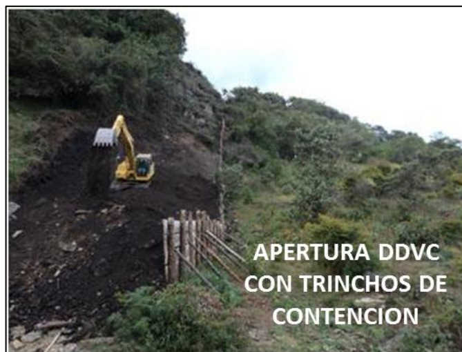
Figura 34. Apertura DDVC con trinchos.
