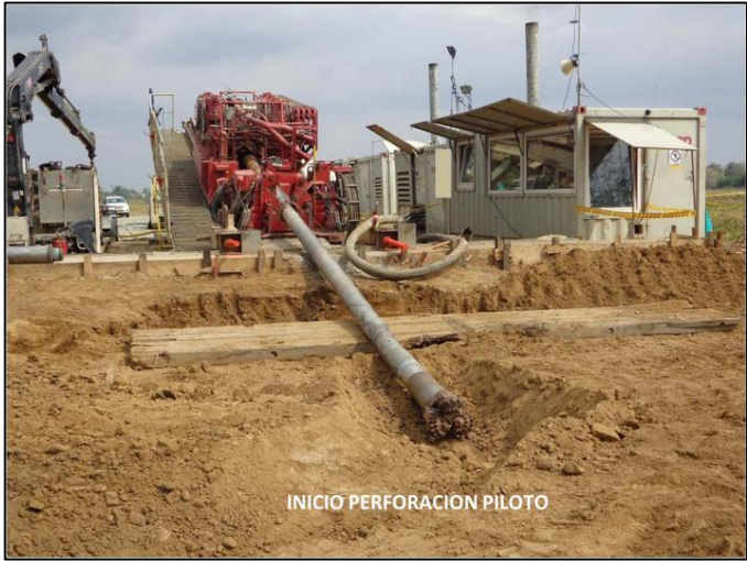
Figura 48. Inicio perforación piloto.
