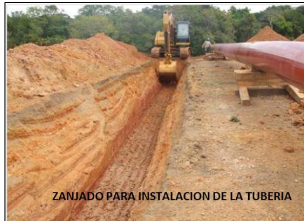
Figura 21. Zanjado de tubería.
