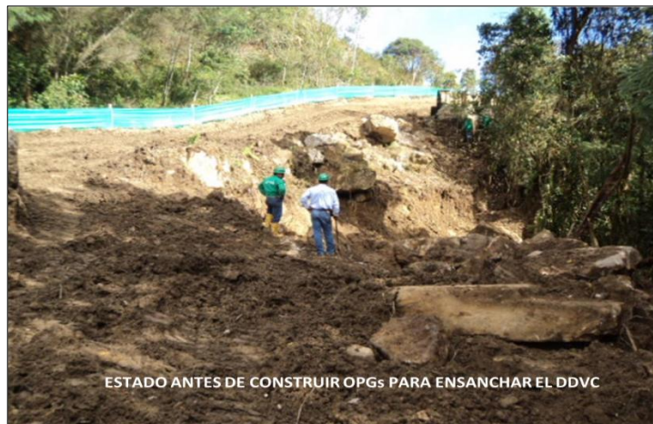
Figura 30. Antes de construir OPG'S para ensanchar DDVC
