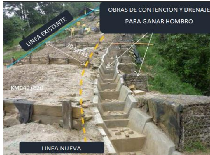
Figura 45. Obras de contención y drenaje para ganar hombro.
