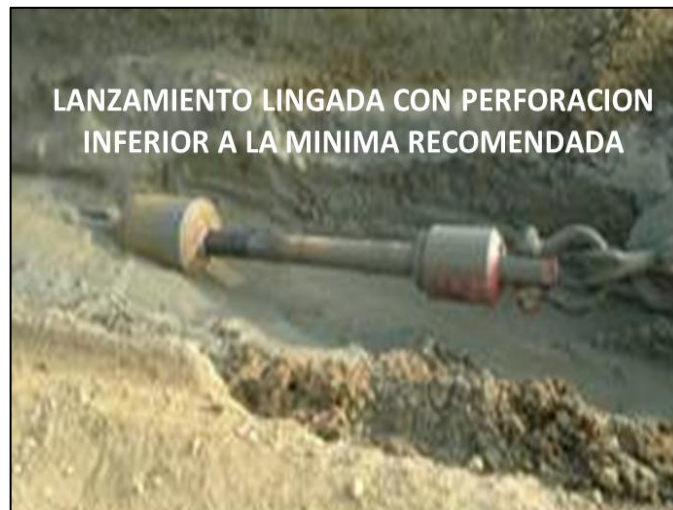
Figura 50. Lanzamiento de lingada.
