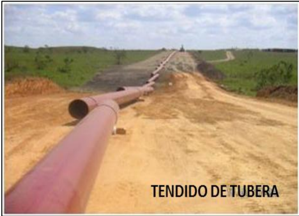
Figura 18. Tendido de tubería.
