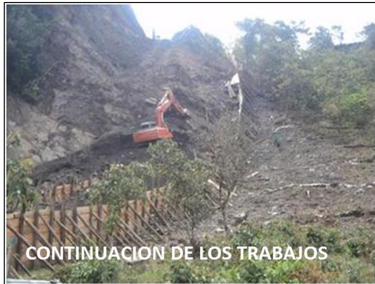
Figura 37. Continuación de los trabajos.
