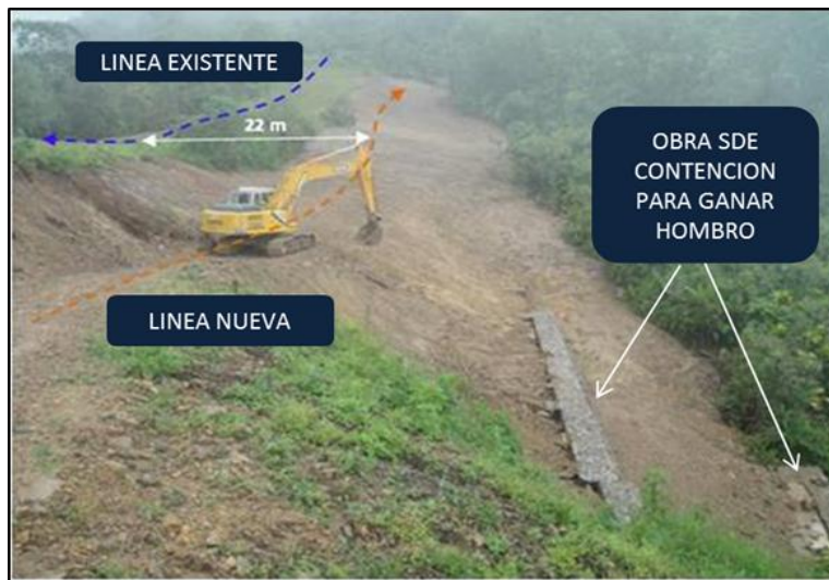
Figura 44. Obras de contención para ganar hombro.
