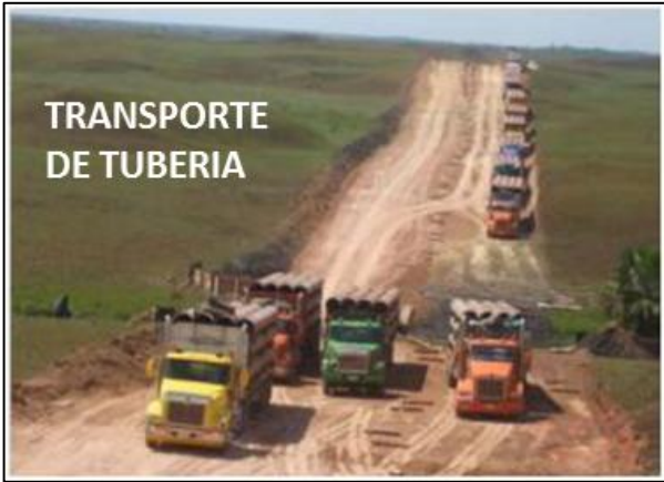
Figura 17. Transporte de tubería.
