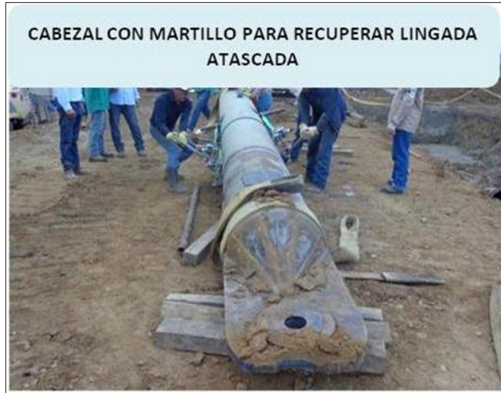
Figura 54. Cabezal con martillo para recuperación de lingada.
