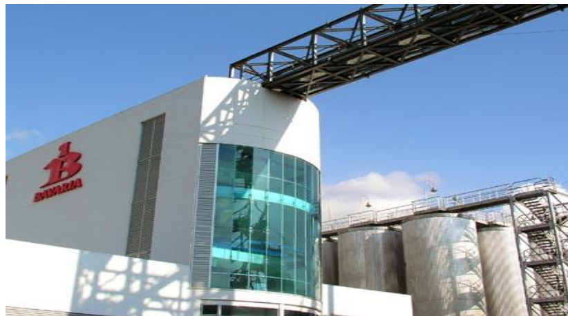
Figura 13. Edificio de cocinas cervecería Bavaria Bucaramanga
