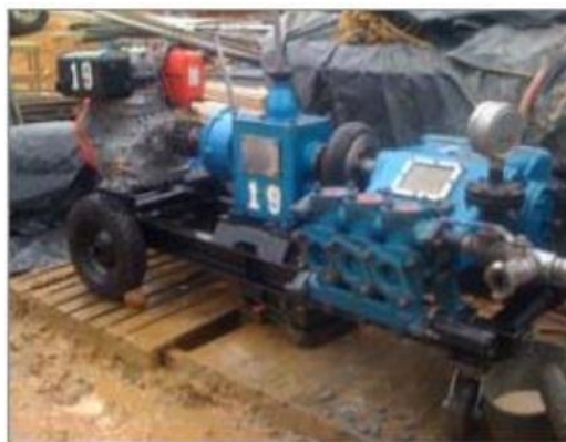
Figura 18. Bomba de inyección Been Royal BW 150.
