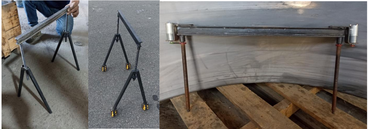
Figura 19. Montaje de estructura metálica
