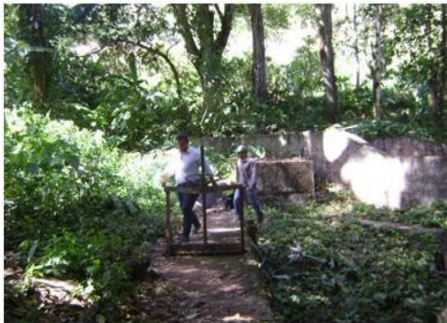
Figura 24. Compuerta paso de agua para acueducto
