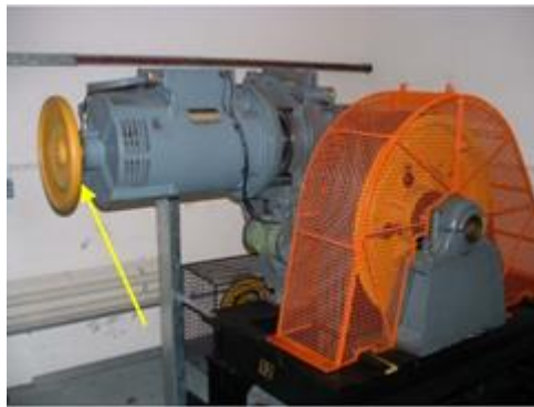
Figura 4 . Volante utilizado para una máquina elevadora. Adaptado de Al-Sharif, L. (2016). Flywheels: Rationale, Formulae and Applications. University of Jordan, Aman.
