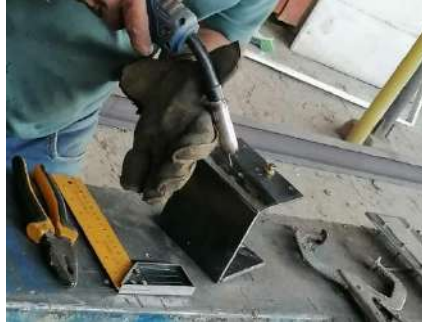
Figura 13. Refuerzo de soldadura bastidor
