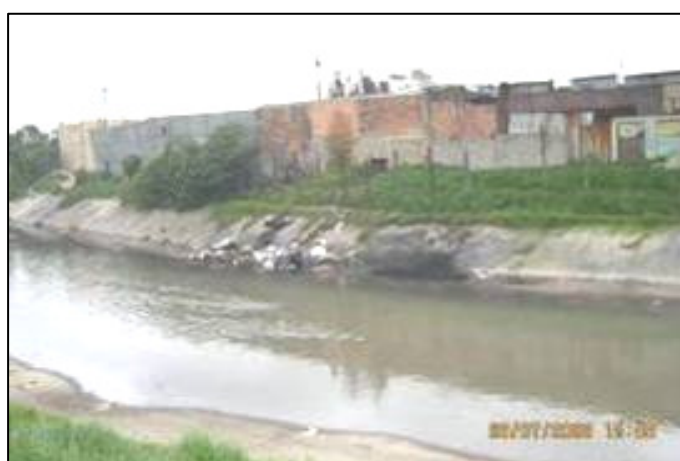
Foto 11. Ocupación de la zona de ronda y ZMPA del río y evidencias de quemadas a cielo abierto de llantas y residuos
