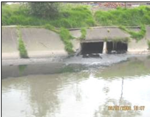
Foto 14. Punto de descarga al margen derecho del Río Fucha (descarga Kenwort), proviene de la red pluvial
