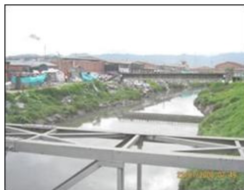
Foto 17. Ocupación de zona de ronda e inadecuada disposición de residuos al margen derecho del cauce
