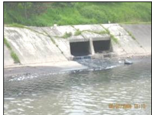
Foto 15. Punto de descarga al margen derecho del Río Fucha 200 m aguas arriba de la avenida Boyacá, proviene de la red pluvial
