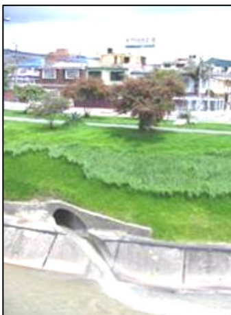
Foto 7. Detalle de la descarga de la estructura de alivio a la altura de la Kr 10 con Dg 12 Sur
