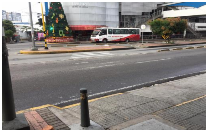
Figura 49. Discontinuidad en la cebra peatonal costado Este.
