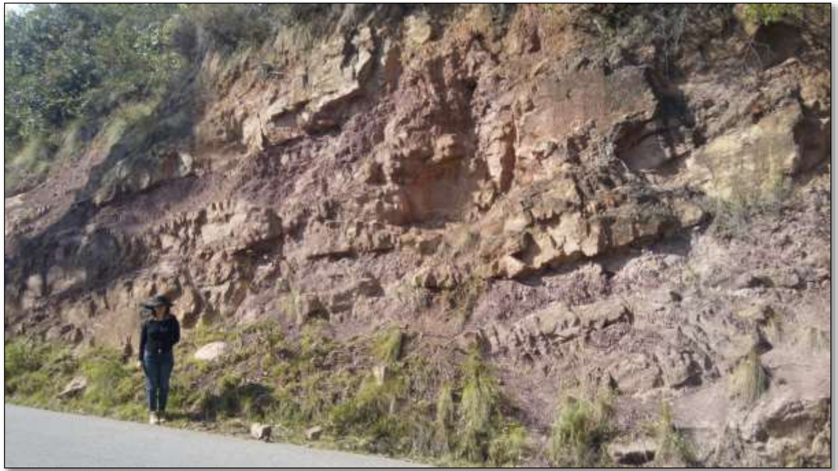
Figura 16. Segmento dos. Intercalación de areniscas con lodolitas masivas. Km 5+800. Vía Santa Rosa de Viterbo- Tobasía.
