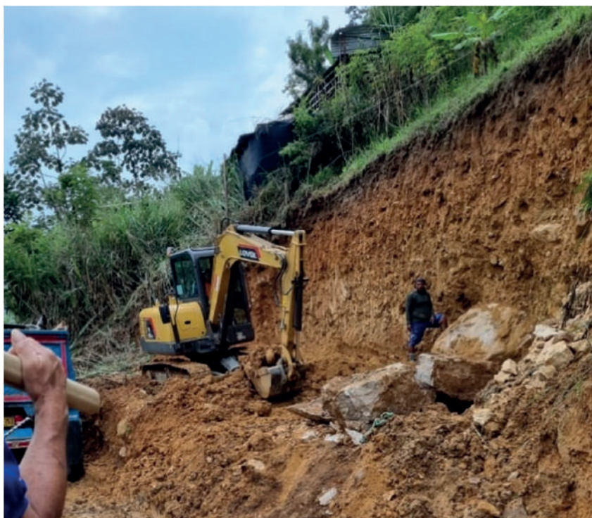
Fotografía 5. Reparación de la vía que comunica Miradores de la UIS con El Porvenir.
