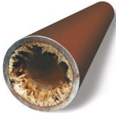
Figura 6. Incrustación en una tubería de producción.
