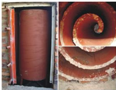
Montaje del intercambiador
