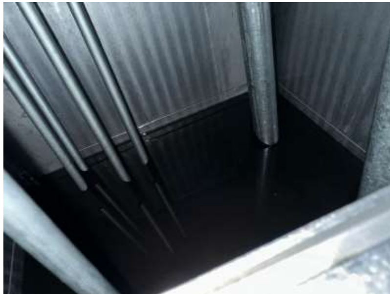
Figura 25. Interior del tanque justo antes de la limpieza de este
