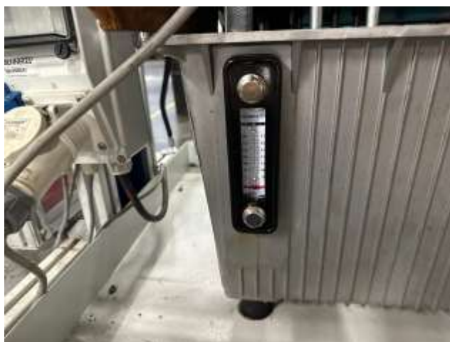
Figura 27. Visor de aceite LS-5 ya instalado
