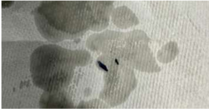
Figura 26. Residuos encontrados al interior del tanque
